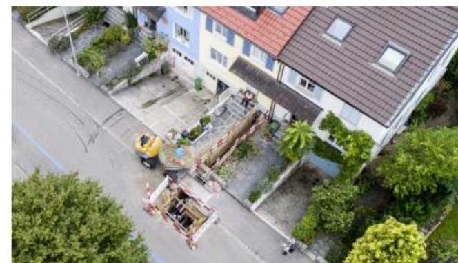
Bau einer Fernwärme-Hausanschlussleitung
