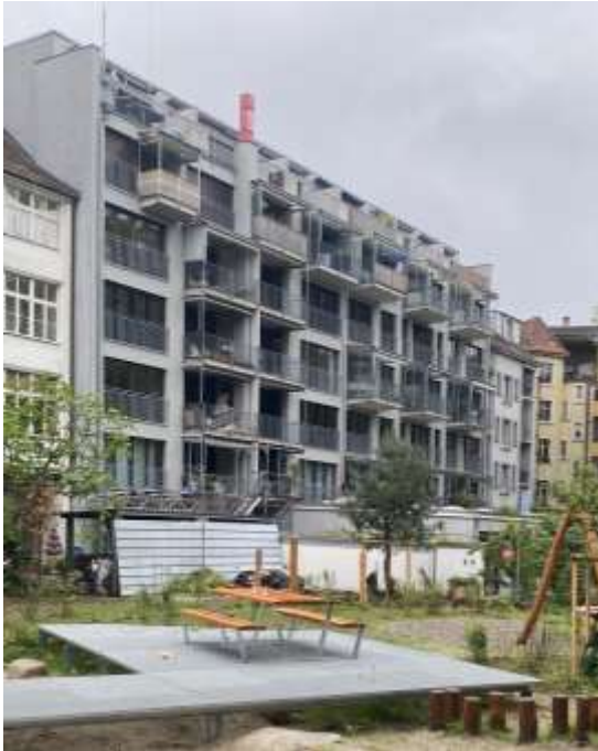
Wohnstadt + WG Elsässerstrasse 131 (2023)
